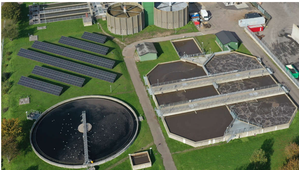
Figur 2. Biosteget vid Lundåkraverket efter ombyggnad.
