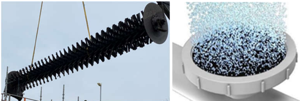
Figur 1. Befintlig valsluftare lyfts bort (t v), membranluftare (t h).
